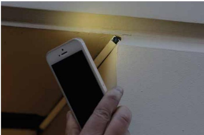
Für die Beleuchtung eines Schaufensters macht es einen großen Unterschied, ob es bewölkt ist, ob die Sonne direkt ins Fenster scheint oder ob es dämmt. Deswegen gibt es bei Depperich einen Sensor, der den Lichteinfall misst. Mit einer Smartphone-Taschenlampe lässt sich der Sensor austricksen.
