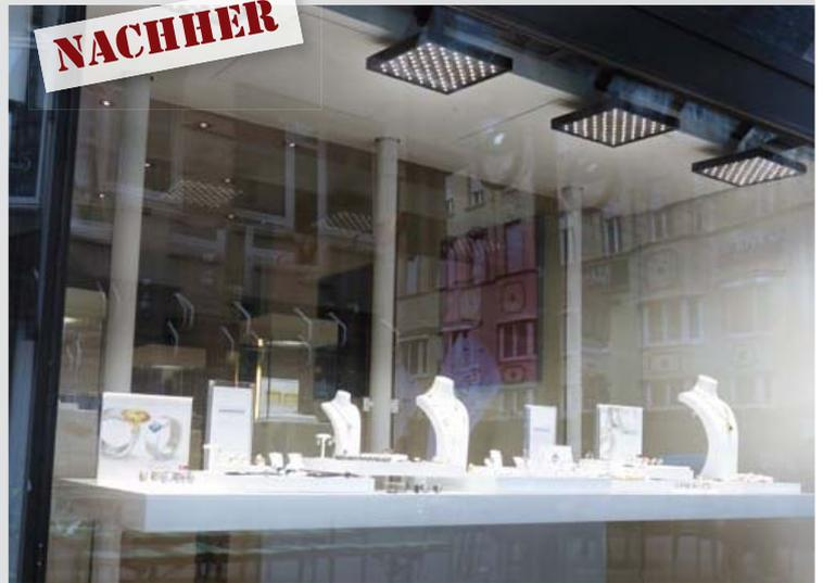
Nun leuchten vier 75 Watt-LED-Platinen. Der Schmuck tritt stärker in den Vordergrund. Ein Außensensor setzt automatisch die Lichtverhältnisse außen und innen ins rechte Verhältnis, die Scheibe spiegelt weniger.
